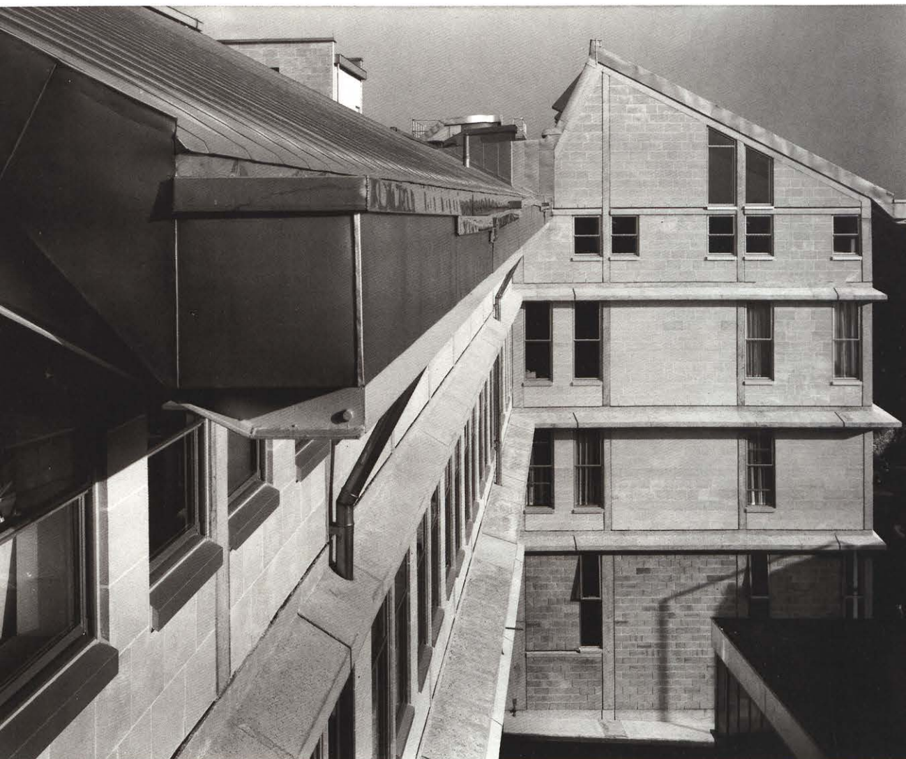
Vista Sur de la zona de servicios desde la cubierta; obsérvese que el canalón desciende en escalera hasta el desagüe. South side view down into service yard from roof level; note stepping down of gutter fascia to rain-water outlet.
